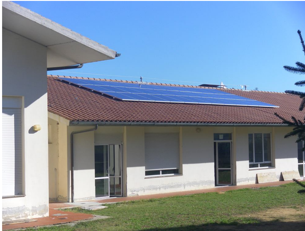
Scuola Elementare Bagno di Gavorrano 8,1 kWp – Gavorrano (GR)
